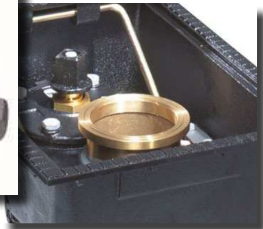
1/2 raccord Keyser mâle sur Bouche d'Incendie normalisée 100 mm
